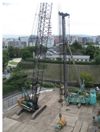
杭打ち工事の様子
