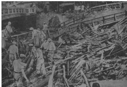
↑ 流された上の橋が原形がそのままひっかかっている井芹川の橋で早くも流木の引き上げ作業が始まった。
