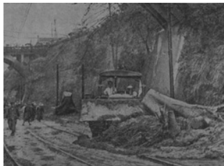
↑ 熊本市新堀橋下崖くずれの復旧作業（巨木の根っこがブルドーザーに押されレッカーに曳かれて片づけられてゆく）昭和32年7月28日
