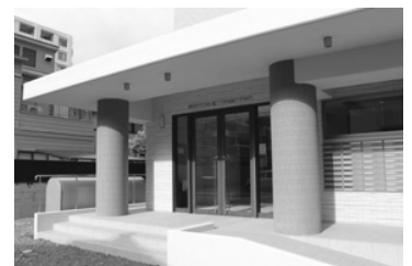
宿舎エントランス
