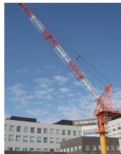
設置されたタワークレーン
