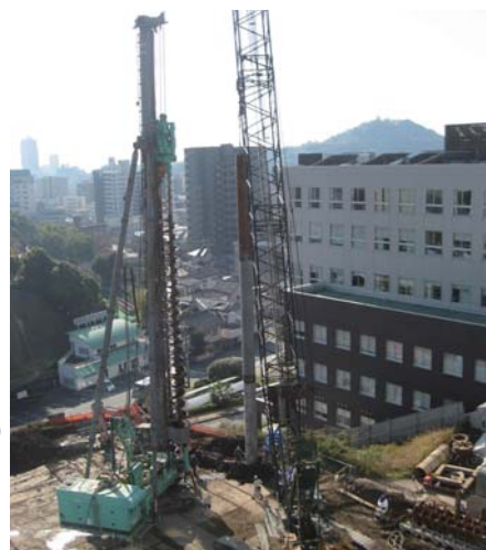
本杭打ち工事の様子
