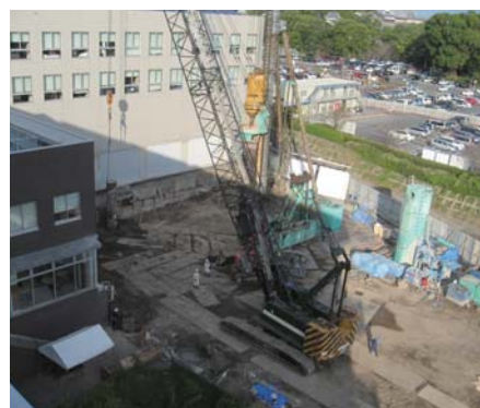
本杭打ち工事の様子
