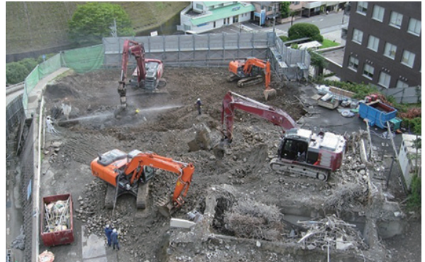
研修棟建物外部解体後
