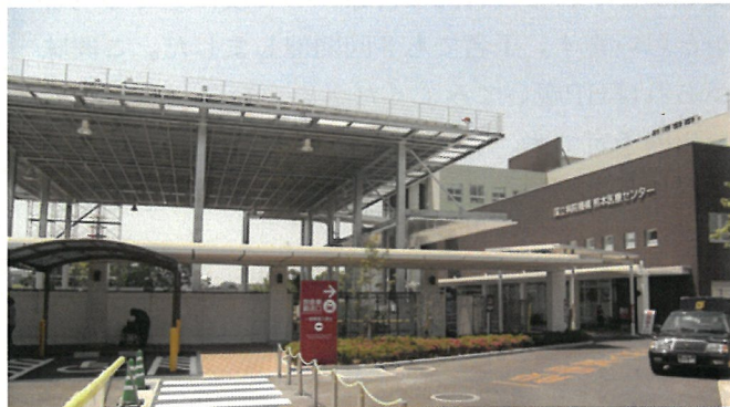
正面玄関前に建設されました。
